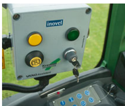
Am Steuerkasten in der Kabine stellt man vom internen auf den externen Fahrbetrieb um.
